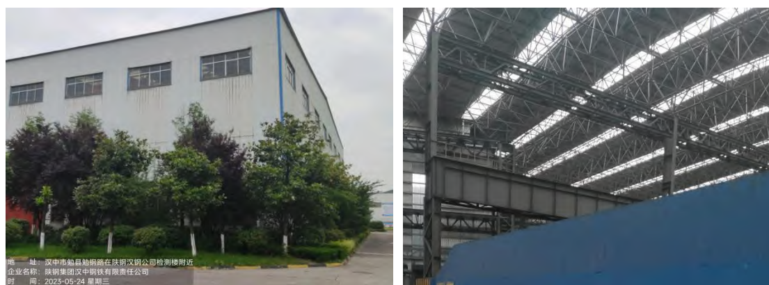
图 5.2-8 成品及物资区现场踏勘照片
