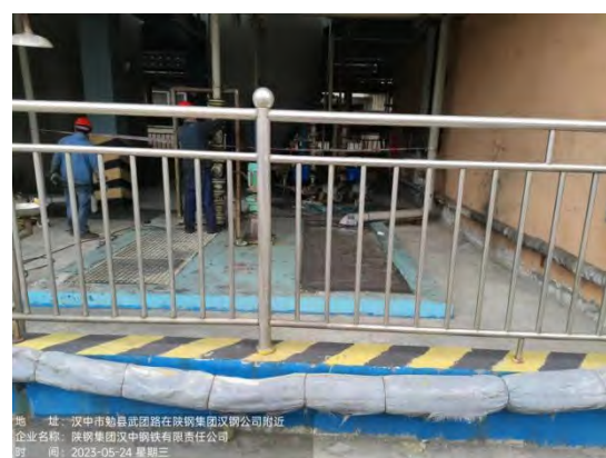
烧结工序地下水池体，深度 2.5m
